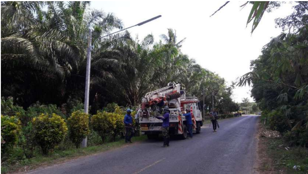
โครงการขยายเขตไฟฟ้าสาธารณะ (ไฟส่องทาง) หมู่ที่๒
